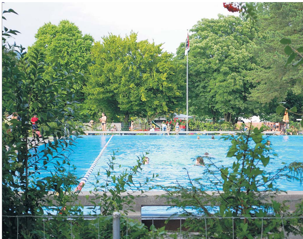
CHARAKTER STÄRKEN Die Aarauer Badi im Schachen soll saniert werden. MARCEL SIEGRIST
